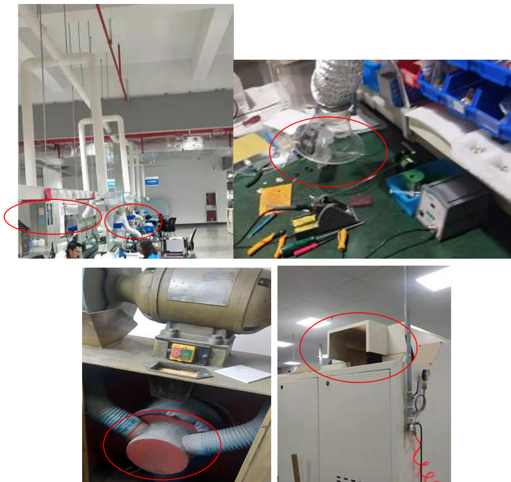
图 3-4 废气处理装置图
