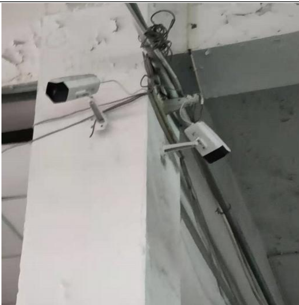
危废仓库监控
